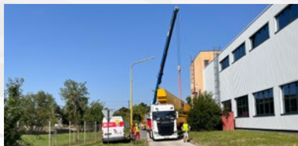
Der neue Kran wird per Schwertransport angeliefert.
