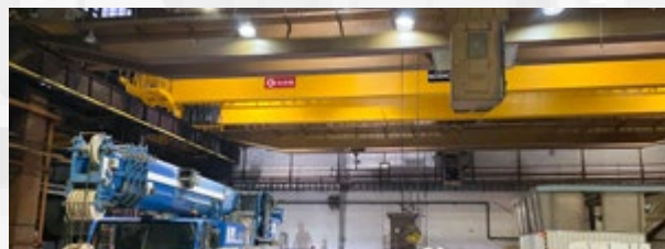
Alles an seinem Platz: Der 20-t-Kran ist fertig montiert.
